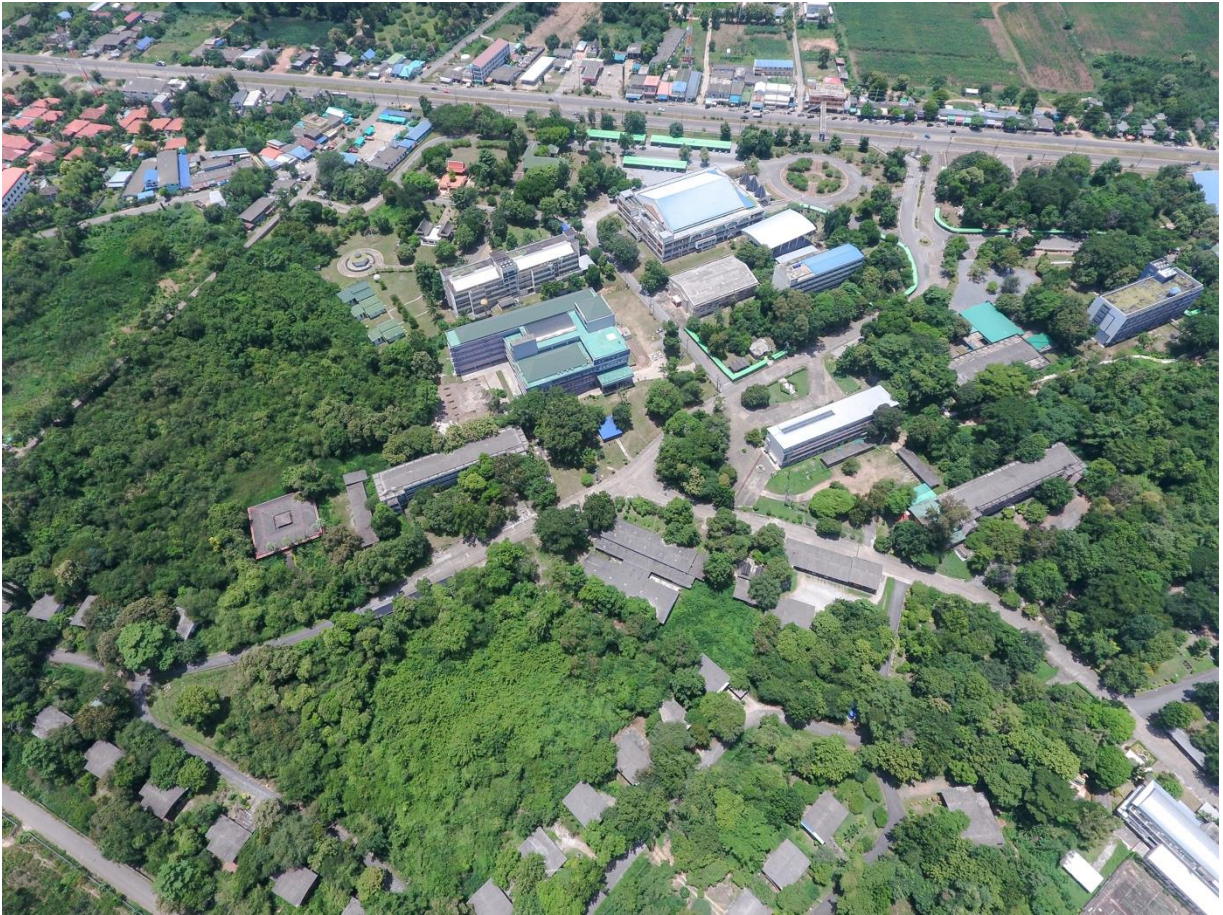
ภาพที่ 6 มุมสูงแสดงให้เห็นด้านหน้าที่ติดถนนเส้นหลักจะมีการเปิดพื้นที่โล่งและมีอาคารคณะวิทยาการจัดการ อาคารคณะวิทยาศาสตร์และเทคโนโลยี และบริเวณอาคารหอประชุมใหญ่
